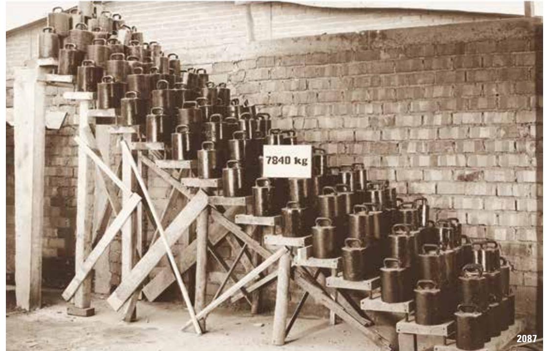
1957 KENNGOTT-TREPPE - Belastungsprüfung
